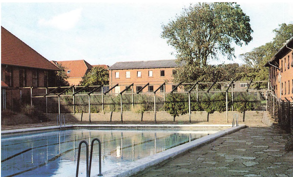
Nyt svømmeanlæg – foran gamle bygninger fra 1892
