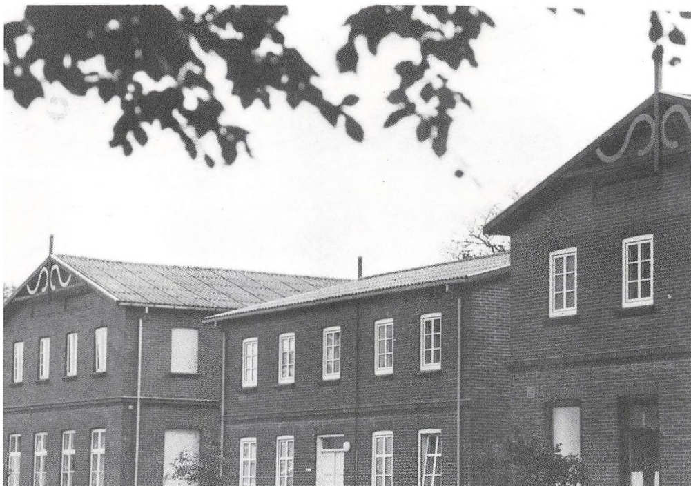
Seminariets gamle bygninger, Sparta, Athen og Theben er blevet renoveret i de forløbne måneder. Nu har de fået fine gavlfignurer som dengang for næsten 100 år siden. Fotos: Poul Lastbein Madsen.
