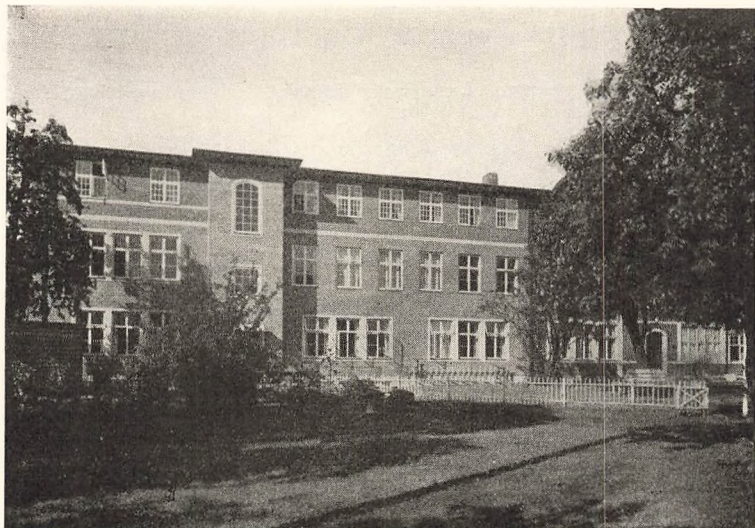
Den nye Bygning, set fra Haven
