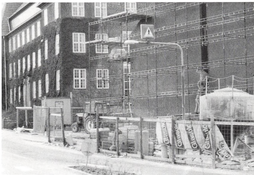
Drømmen er bristet! Teknisk Skoles byggeplads 1987.
