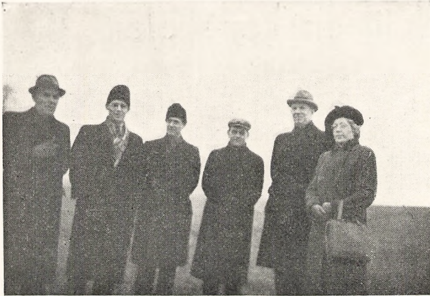
Lejrskoleudvalget inspicerer Byggegrunden ved Bastrup Sø.
