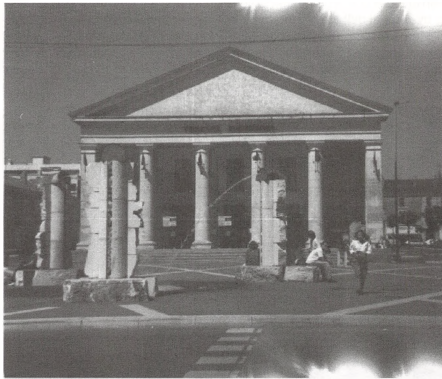
"Theatre Municipal" i La Roche sur Yon.
