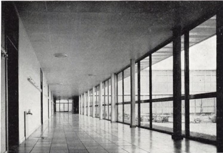
Korridor i sydflojen
