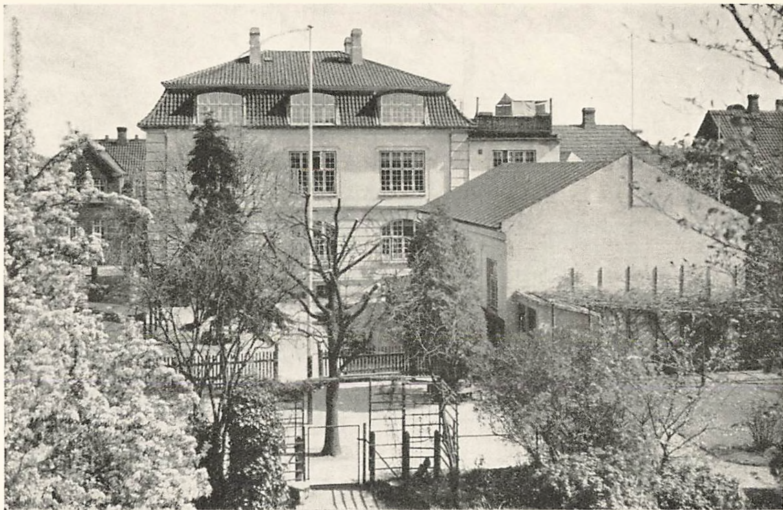
Skolebygningerne og de to Legepladser — Underklassernes Legeplads i Forgrunden.
