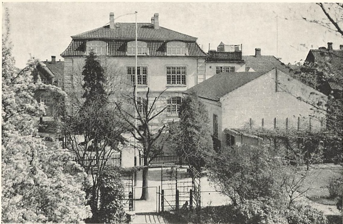
Skolebygningen og de to Legepladser — Underklassernes Legeplads i Forgrunden.
