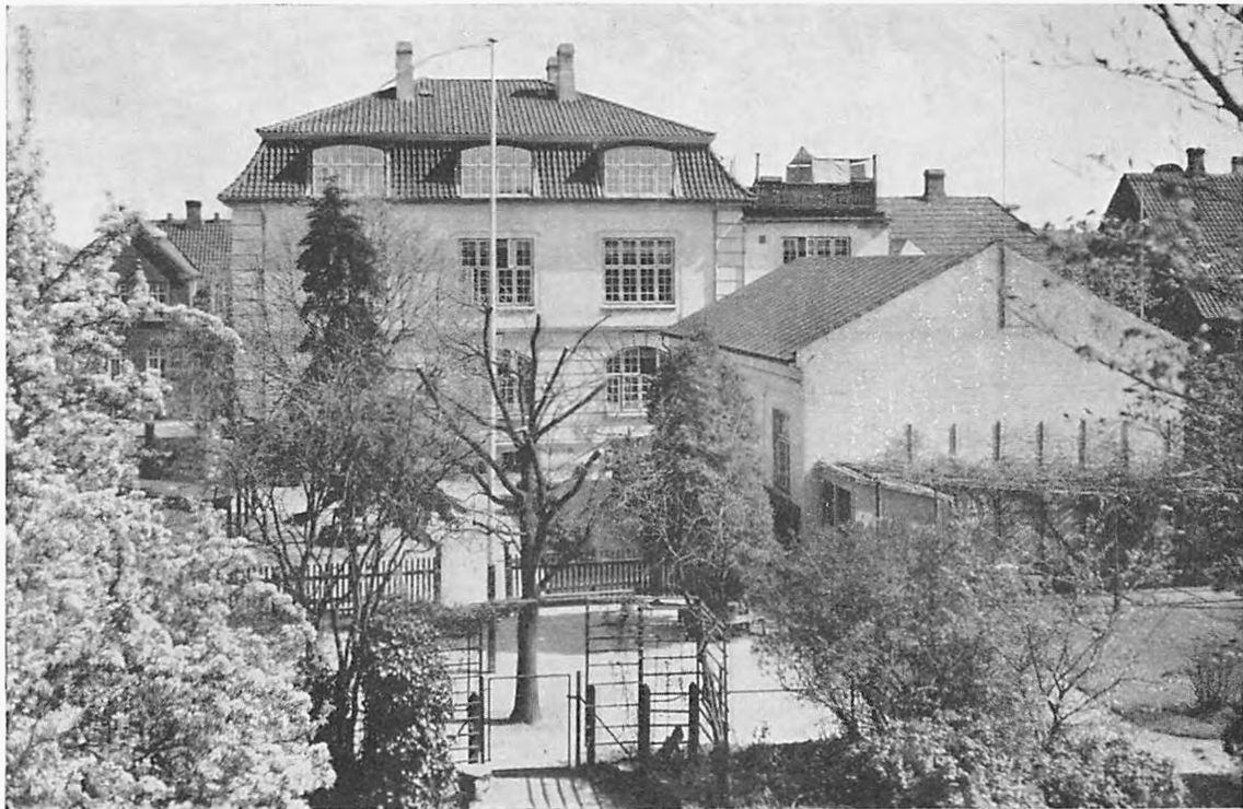
Skolebygningen og de to Legepladser — Underklassernes Legeplads i Forgrunden.
