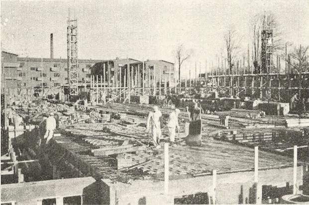
2. Die Decke über dem Kesselhaus' wird gegossen.
