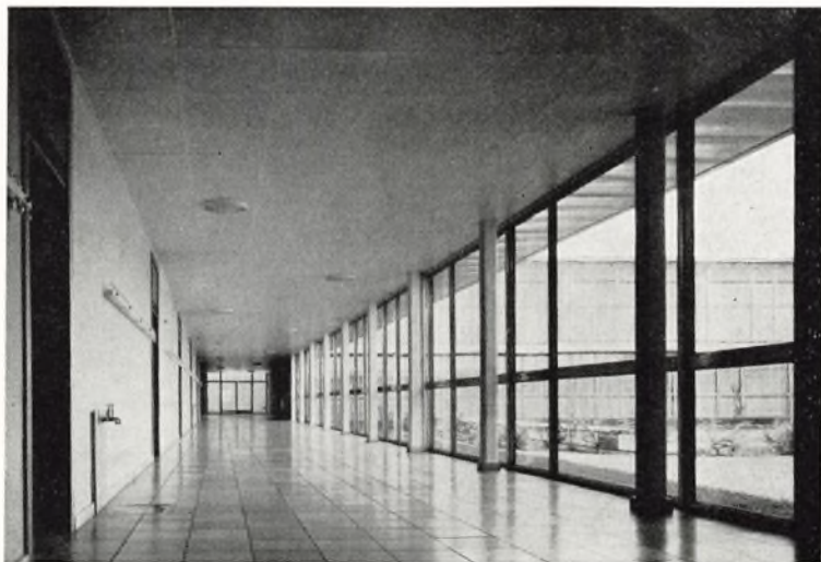
Korridor i sydflojen
