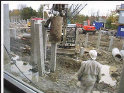
Toppen af piloteringspælen sprænges bort - november 2004
