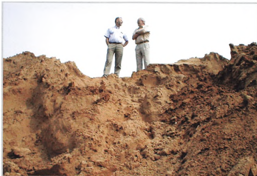
Formanden for bygningsudvalget Carl Erik Mose Hansen og daværende rektor Ole Visti Petersen skuer ud over udgravningen til idrætshal
