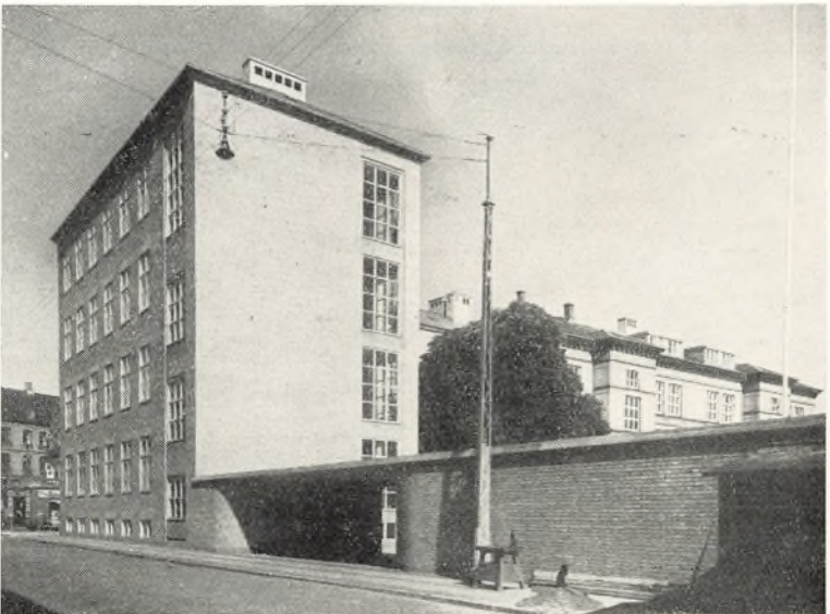
Tilbygningen set fra Valdemarsgade
