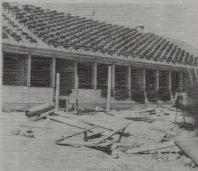
Kantinen under opførelse 1957.
