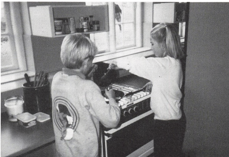
Der arbejdes ved et af de nye komfurer.
