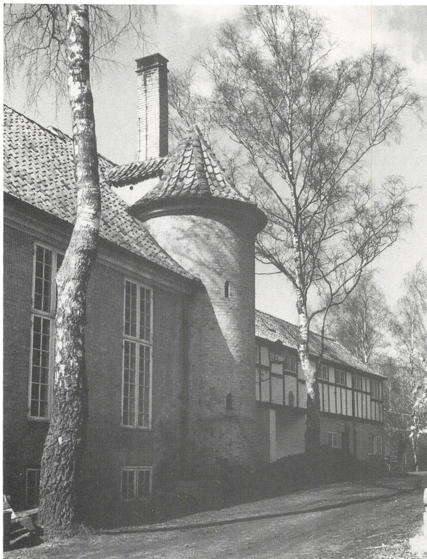
Tårnet, som fra at have været et stemningsskabende element i Niels Munk Plums herskabelige bolig, i dag er bolig for en kostelev. Bygningen til venstre med de høje vinduer tjener som spisesal for kosteleverne.
