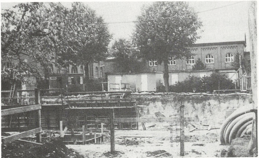
Opgravning til den nye naturfagsfløj. Bygning D.
