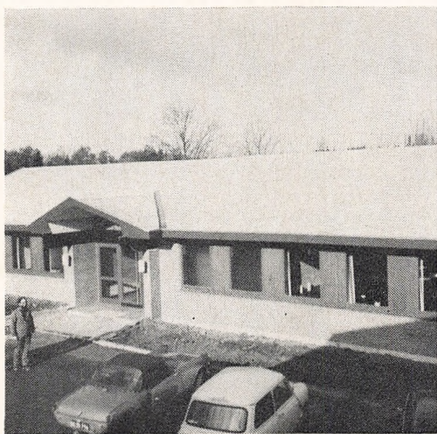
Nybyggeriet set fra stærekassen i april og november.
