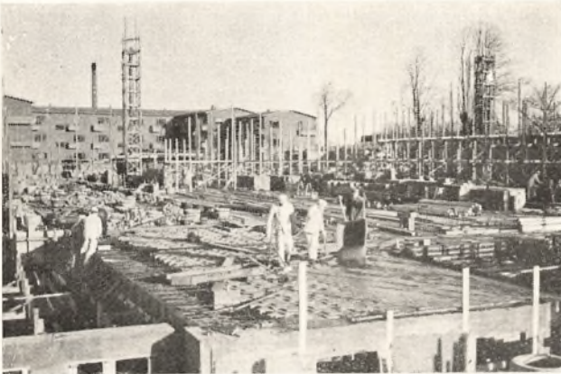
2. Die Decke über dem Kesselhaus' wird gegossen.
