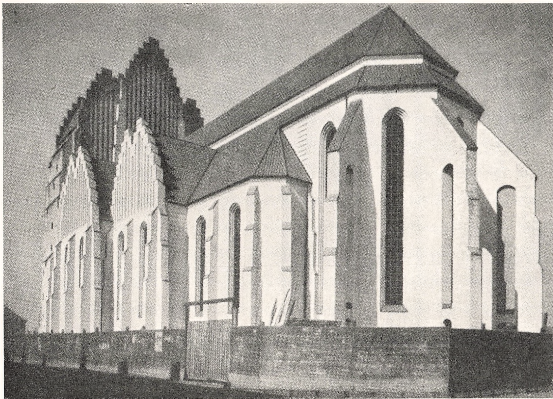
Grundtvig-kirken set fra sydøst. (Plankeværket indhegner byggepladsen).
