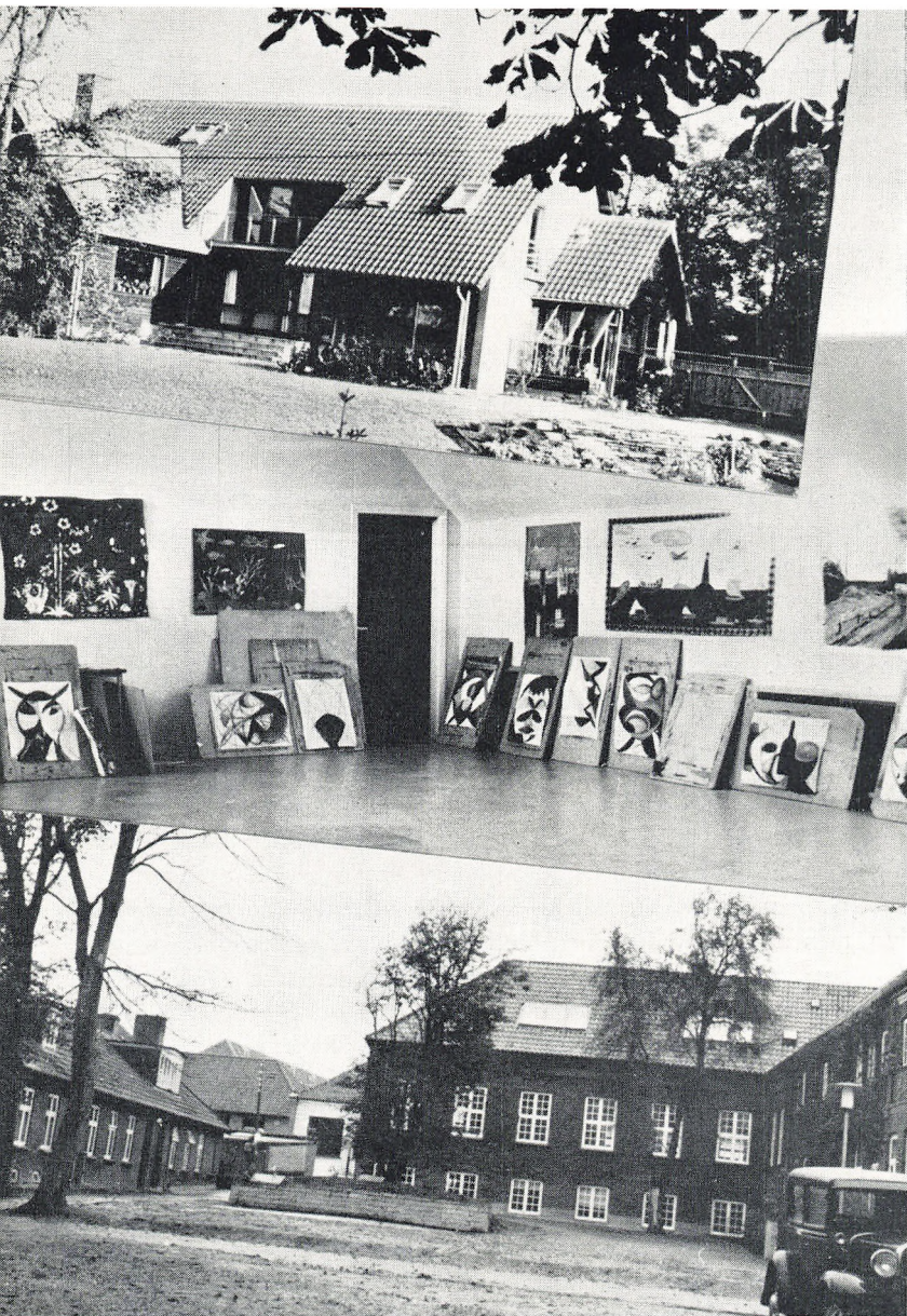
gennem pergolaen, over svømmebassinet til en del af gymnastiksalsafdelingen. 3. Den nye undervisningsbygning enkelte heldige træer.
