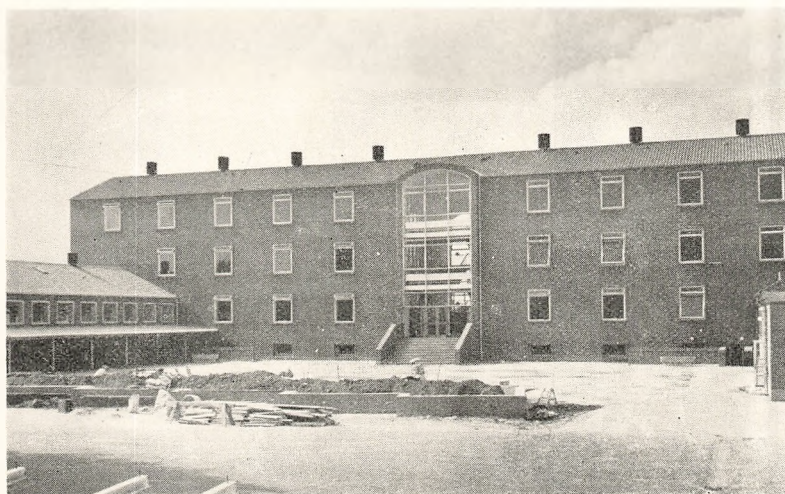
Kettevejsskolens nye Fløj (set fra Gaarden). I Forgrunden arbejdes med Midteranlægget.
