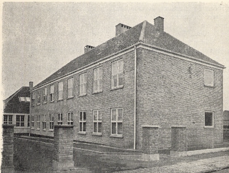
Den nye tilbygning til 1911-bygningen set fra Østergade
