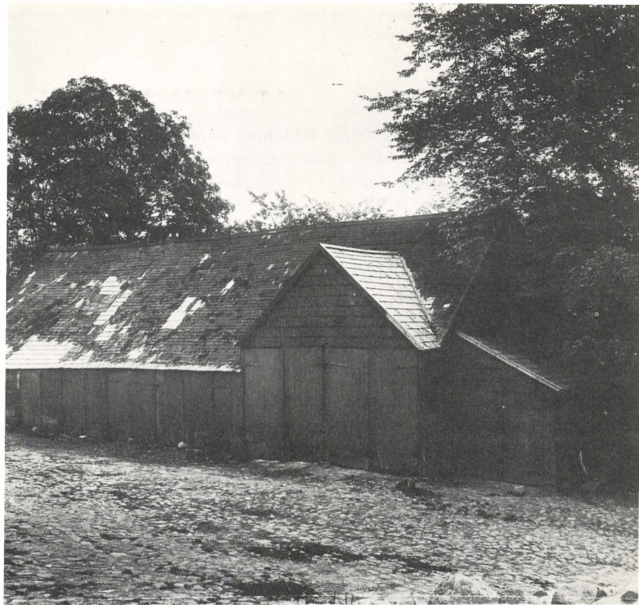
Det gamle øvelseshus ved Vallekilde Højskole 1871-1944. Efter 1884 blev der sat porte i væggen ud mod vejen, så huset kunne bruges som skrammelplads og vognport. Som gymnastiksal var der ovenlys. Vinduerne var anbragt øverst i taget.
