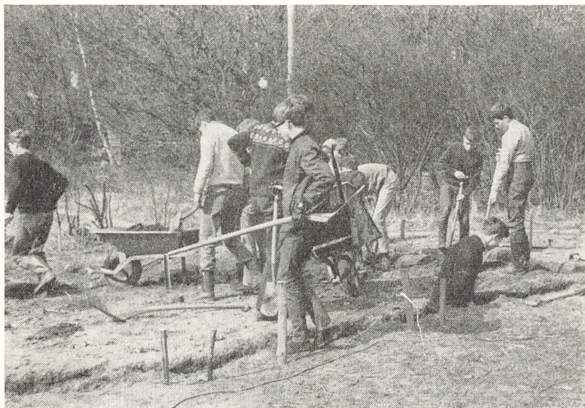
2.r.a. graver ud til lejrens ny bygning.
