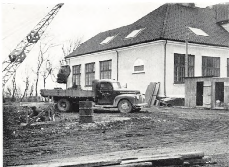
Grunden udgraves til den nye bygning
