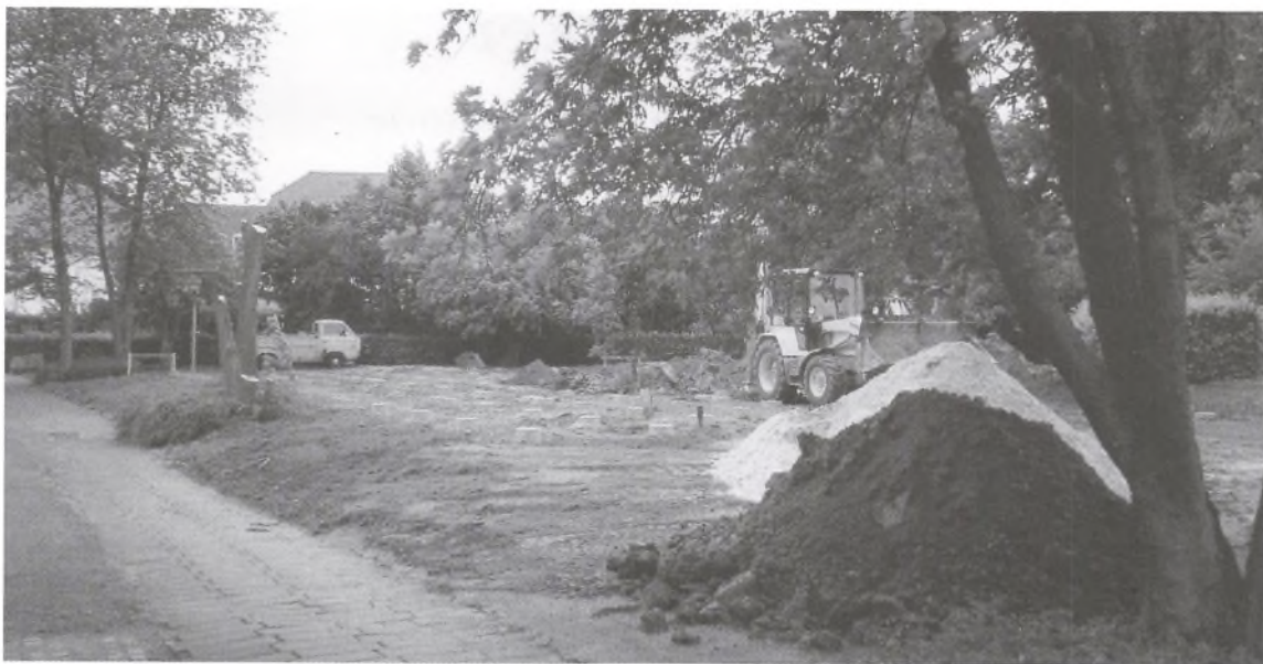
Fundamentet er i orden.
