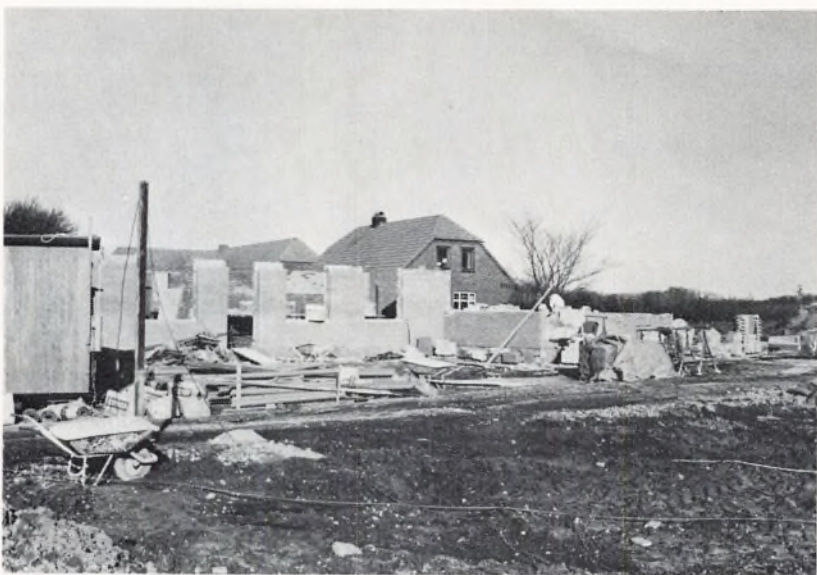
Boligbyggeri ved Nr. Borum – før
