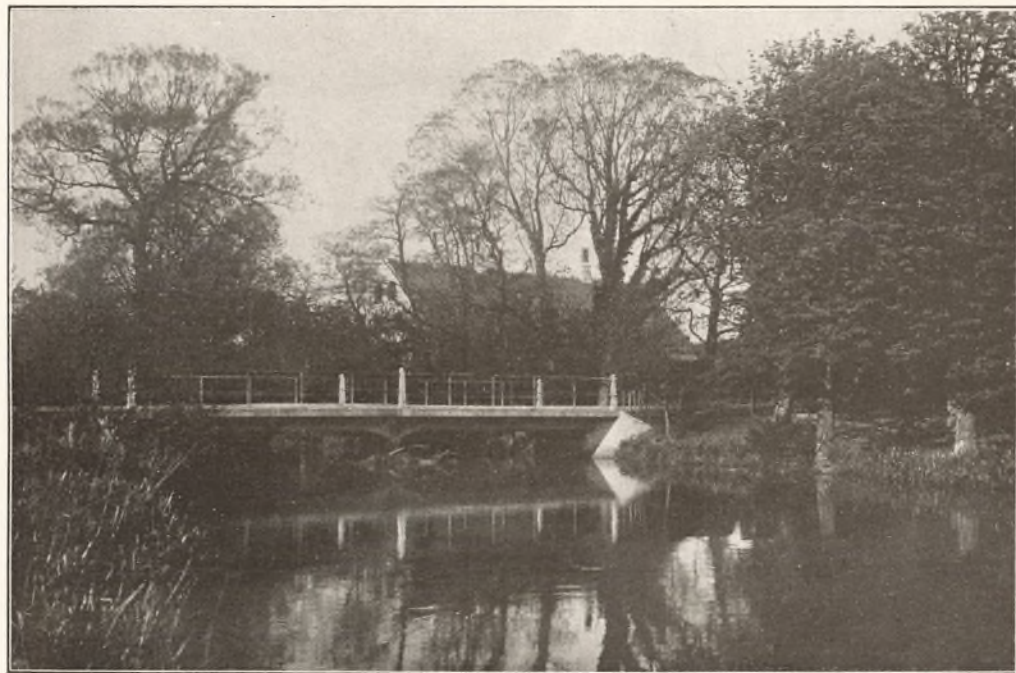
Landevejsbroen over det gamle Aaleje.
