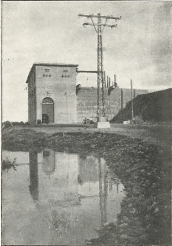
Højspændingsværket, hvorigennem Aaen løber med 10-Meter Fald.
