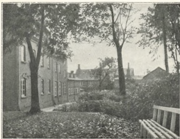
Under de store Træer paa den nye Plæne.
