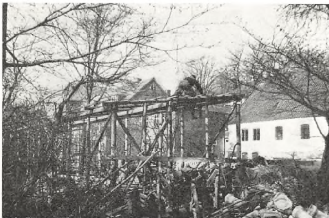
Den første nedrivning
