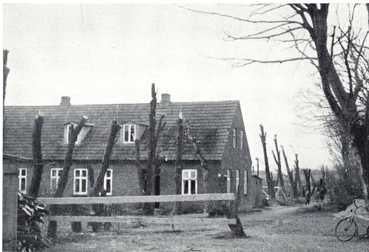
Gadegaards hus umiddelbart før nedbrydningen.
