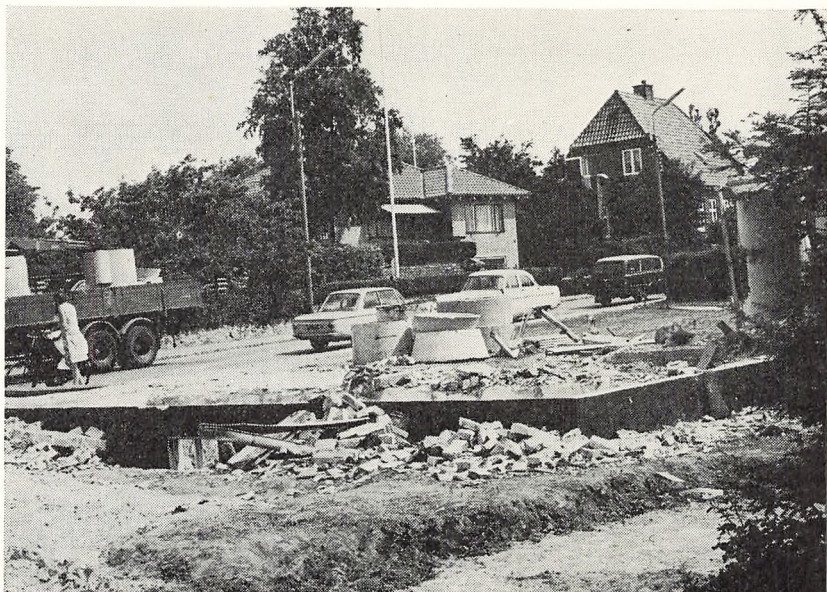
Ved byggeriets begyndelse
