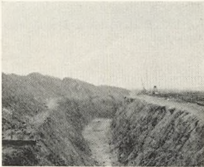
»Skjttegravene til rørledninger
