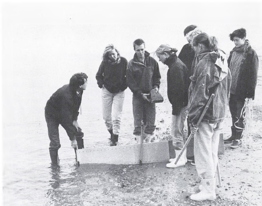
Bygning af forsøgshøfder ved Liseleje. Foto: Martin Thaarup Andersen.
