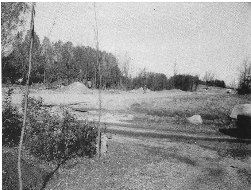
Arbejdet på den nye ABILD-vejen til Scanway-kroen.
