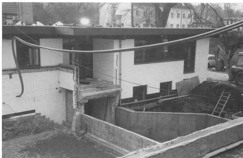
Byggepladsen set fra Pau's tag.
