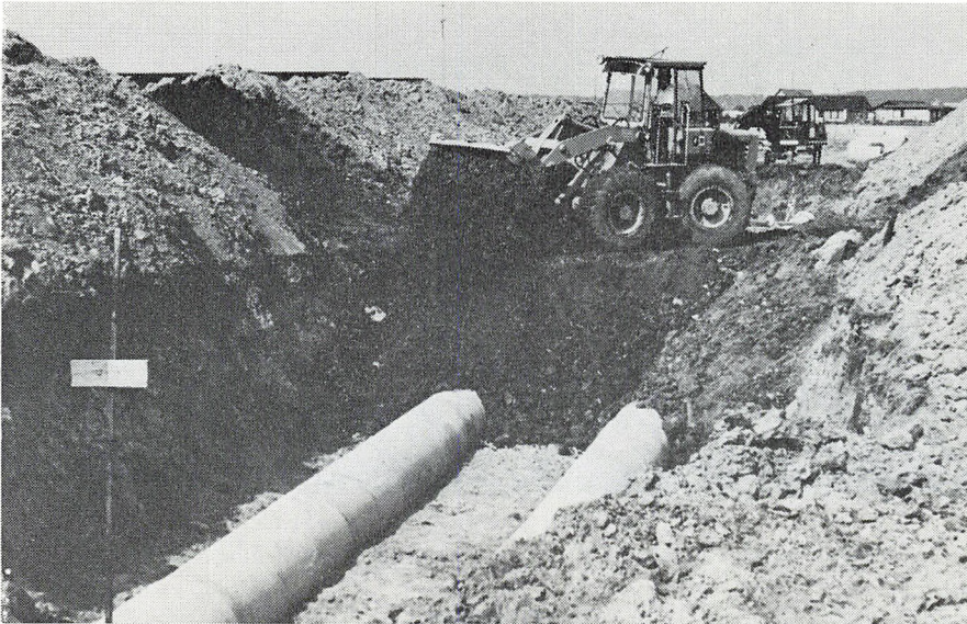
Omlægning af regnvandsledning ved Lindeskovskolen
