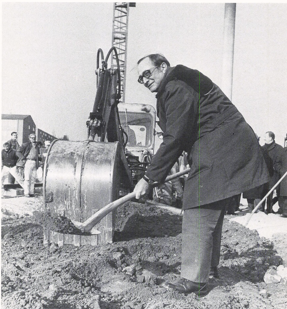
SANGSKOLENS gode ven igennem mange år fhv. skoledirektør Kr. Thomsen Jensen, da første spadestik til den nye skolebygning blev taget.
