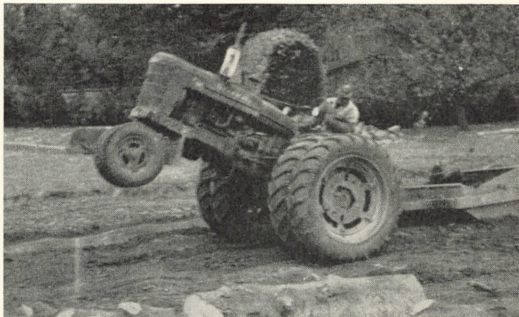
Udgravningen begyndte med maskinkraft.
