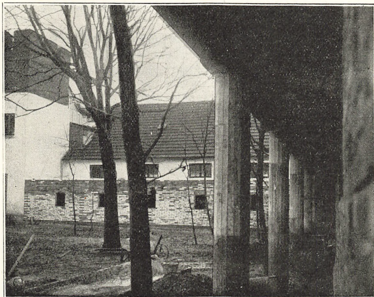
Gården under arbejde.
