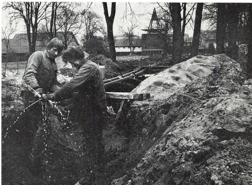
Den ny fjernvarmeledning afprøves. (F. T. fot.)
