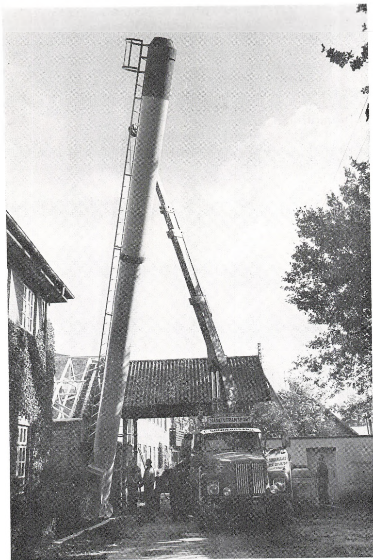
Skorstenen rejses på varmecentralen. Efterår 1983.
