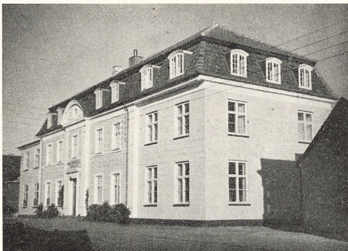
Den ny tilbygning.
