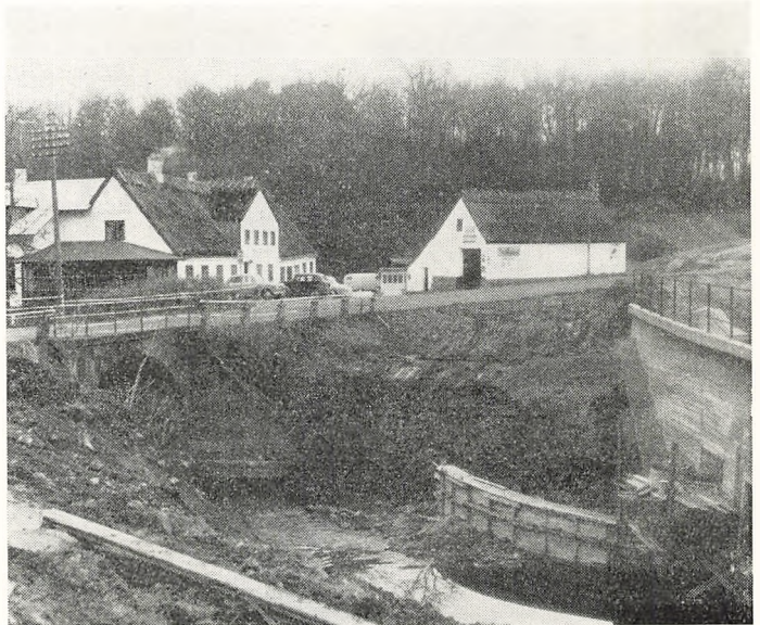
Bro Mølle kro, som den ser ud under vejarbejderne. Bevares idyllen?
