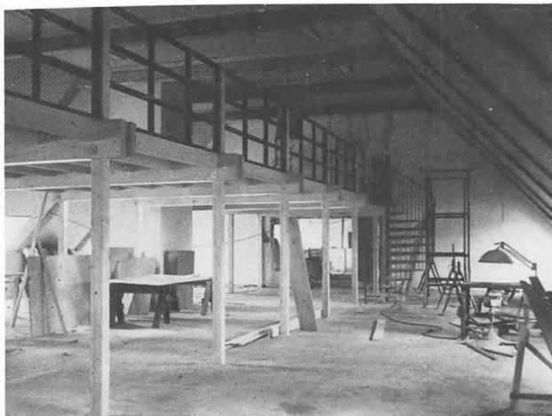
»Loftet« under opførelse.
