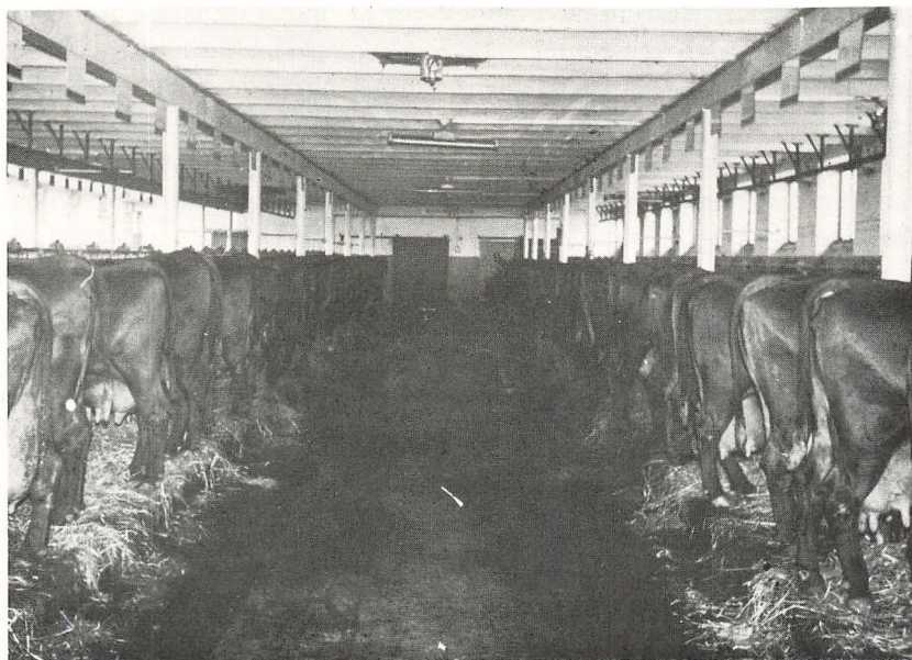
Fra staldene efter ombygningen 1958.
