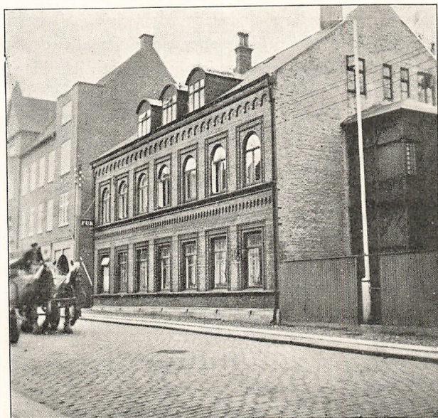
Stormgade, Esbjerg, hvor Arbejderhøjskolen havde til Huse Vinteren 1915—16, Sommeren 1916 og Nov.—Dec. 1916. Hvor det høje Naboehus ligger, var dengang Have
