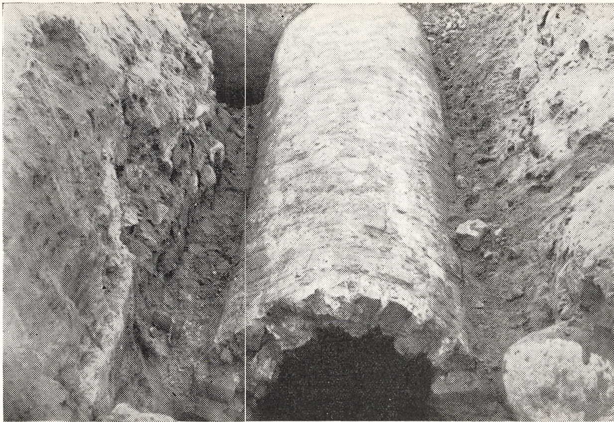
Et Stykke af den udgravede og igen tildækkede Vandledning.
